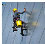
Serviços de instalação e/ou manutenção em esquadrias, vidros etc
