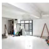
Obras civis de reforma, benfeitorias, incluindo as unidades internas dos aptos e lojas comerciais
