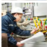
Instalação e/ou manutenção de geradores
